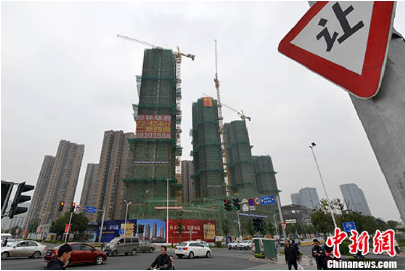
资料图 楼房建筑工地。中新社记者 吕明 摄
