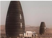
3D打印出的火星住宅
